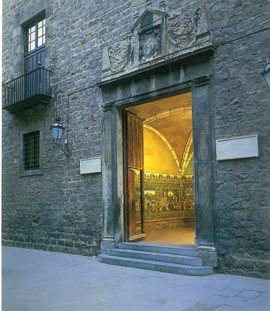
Entrada principal de la Casa de Convalescència. A la llinda —que és coronada per un escut de l'Hospital de la Santa Creu— una llegenda recorda que la col·locació de la primera pedra s'esdevingué l'any 1629. A l'interior hom pot veure part d'una de les aristes de la magnífica volta del vestíbul i també part dels bellíssims plafons de ceràmica historiada, obra dels tallers de la família Passoles.
