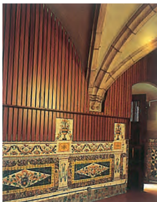
Antic menjador dels homes, a la planta baixa. A més dels arambadors de ceràmica, la fotografia interessa especialment pel detall del punt d'arrencada d'una de les voltes que sostenen el sostre. La bellesa d'estructura i la riquesa decorativa d'aquestes voltes són freqüents en la majoria de les estances de la planta baixa.
