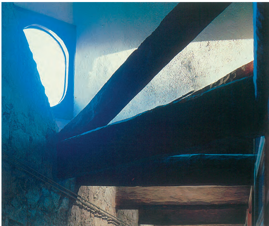
El segon pis de la Casa fou dedicat a bugaderia i magatzem de robes. No té doble sostre i per això queda a la vista l'estructura de les grosses bigues que suporten la teulada a dues aigües. Detall de l'encreuament de les bigues en un dels angles.
