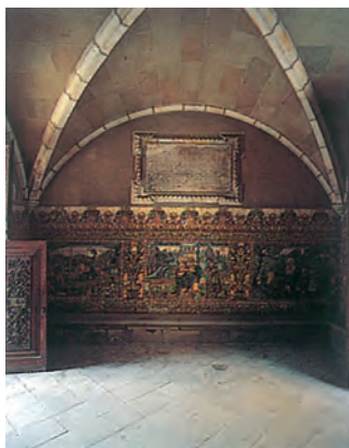
Interior del bell i espaiós vestíbul d'entrada a la Casa de Convalescència, que dona directament al claustre. El detall reproduïx la làpida commemorativa de la fundació, col·locació de la primera pedra i inauguració de l'edifici.
